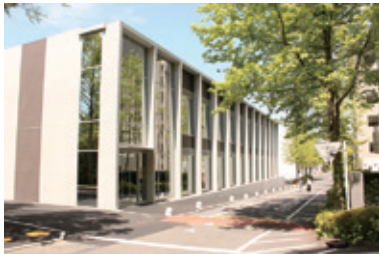
27 フロンティア研究棟
