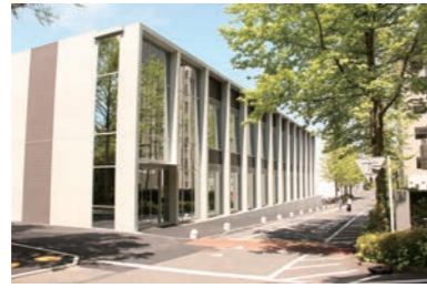
27 フロンティア研究棟
