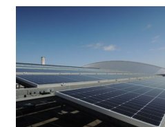
〈太陽光パネル改修工事〉 〈南大沢キャンパス〉
