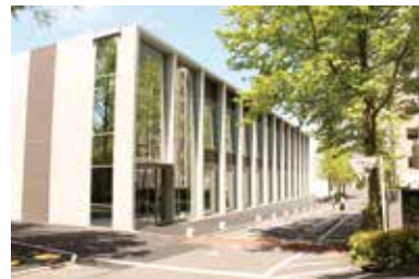
27 フロンティア研究棟
