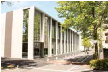
27 フロンティア研究棟
