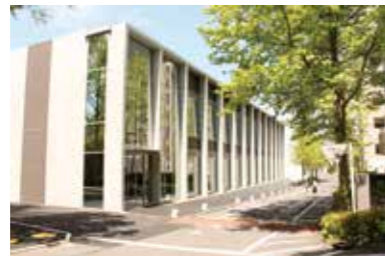
27 フロンティア研究棟
